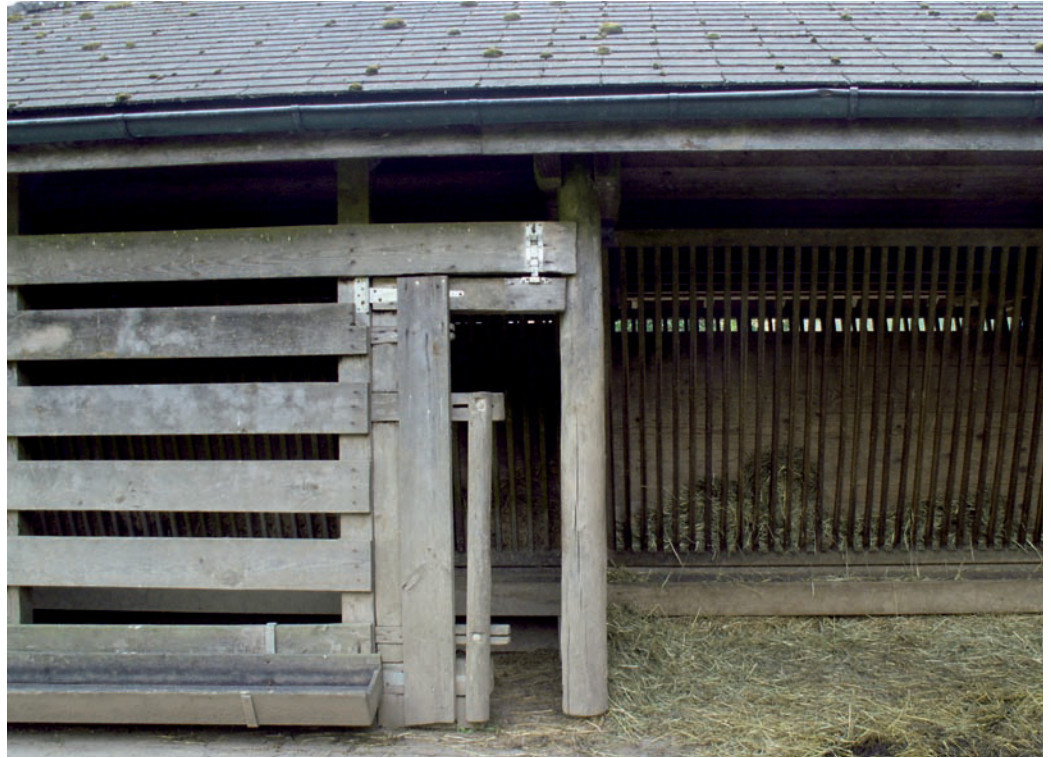
Jungtierschlupf für Rothirsche: Er liegt direkt neben der Futterstelle der Alttiere und ist in der Breite einfach verstellbar.
